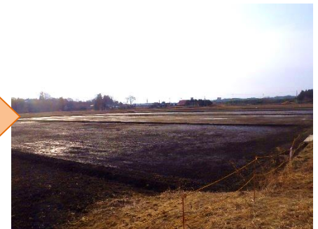
整地（均平化）終了時
