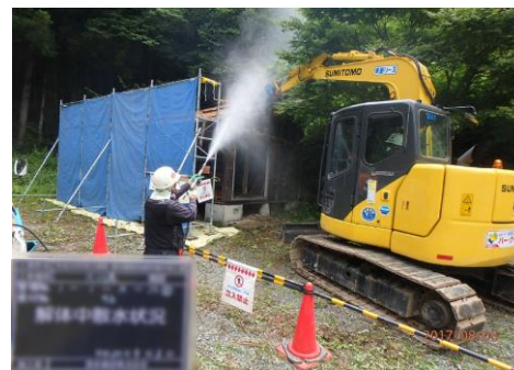
被災家屋等の解体の様子
