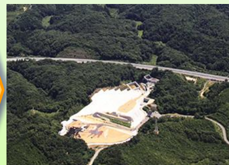
特定廃棄物埋立処分施設 (旧フクシマエコテック クリーンセンター)
