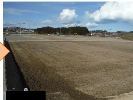
整地（均平化）終了時
