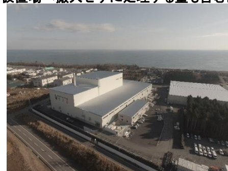
大熊町の仮設焼却施設
