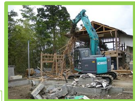
被災家屋等の解体
