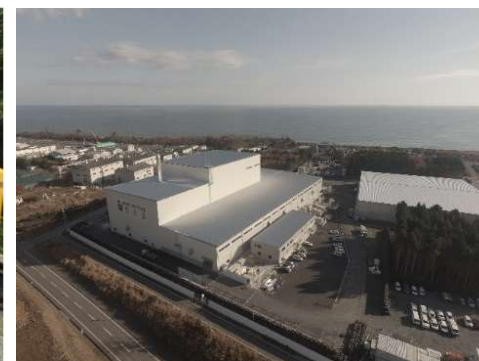
大熊町の仮設焼却施設
