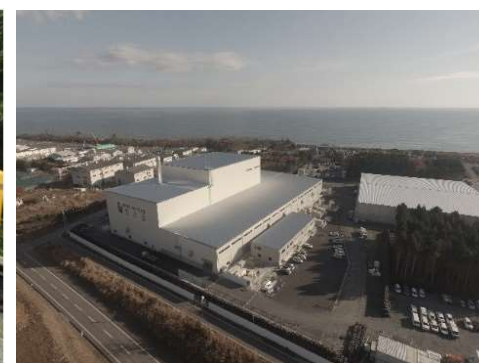
大熊町の仮設焼却施設
