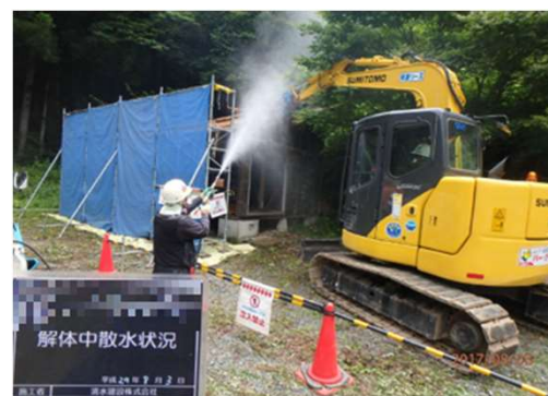
被災家屋等の解体の様子
