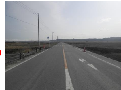
撤去後(平成28年3月)
