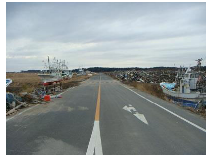
撤去前(平成26年7月)
