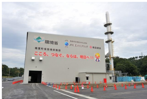
楢葉町の仮設焼却施設 (平成28年10月)
